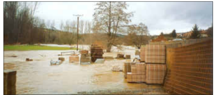
Unsachgemäße Lagerung in Überflutungsbereichen (Quelle: Landesamt für Umwelt- und Arbeitsschutz)
