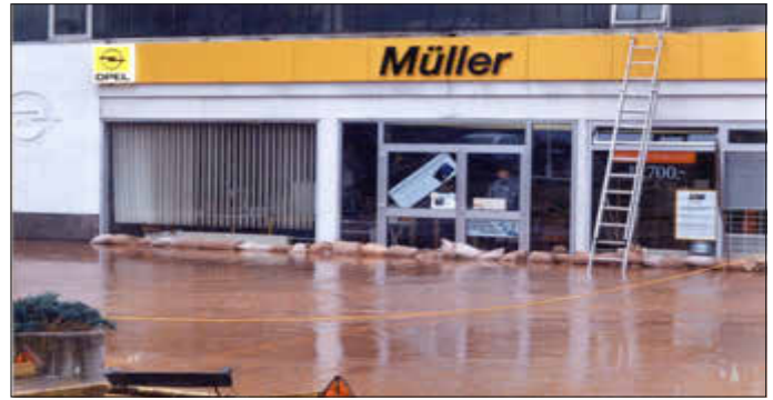
Schadenspotenzial durch Bebauung in Überschwemmungsgebieten (Quelle: Landesamt für Umwelt- und Arbeitsschutz)
