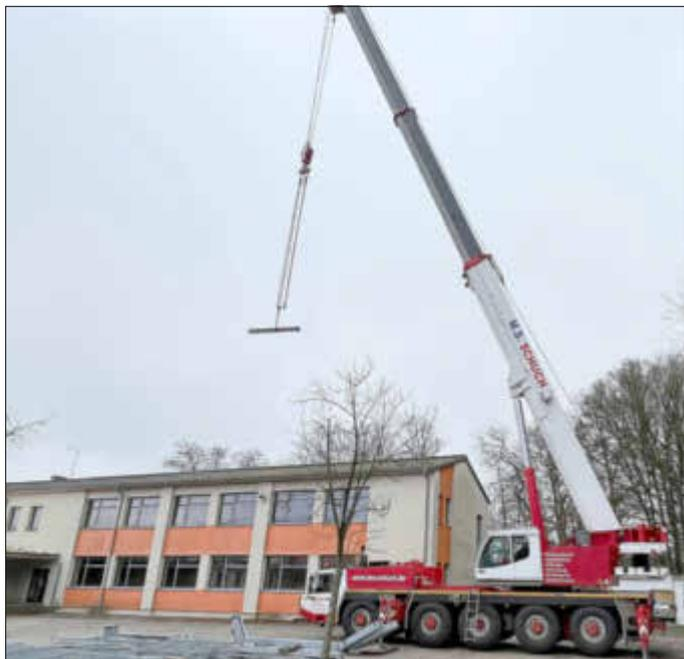
Die Teile für die beiden Treppentürme in Fischbach-Camphausen wurden mit Hilfe eines über 20 Meter hohen Krans platziert.
