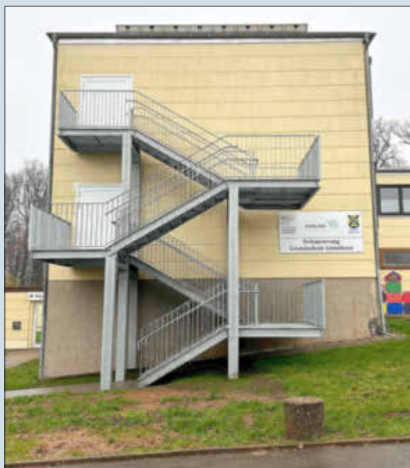
Ein Beispiel: Die neue Fluchttreppe an der Grundschule in Göttelborn erhöht den Brandschutz.
