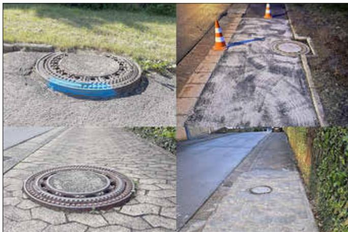
In der Umlandstraße und an einer weiteren Stelle in der Nähe der Grundschule wurde der Gehweg jetzt so angepasst, dass er eben- erdig mit den Kanaldeckeln abschließt. Die Stolpergefahr ist damit beseitigt. Wir bedanken uns bei Herrn Kallenbach für die schnelle Umsetzung der beiden Maßnahmen.
